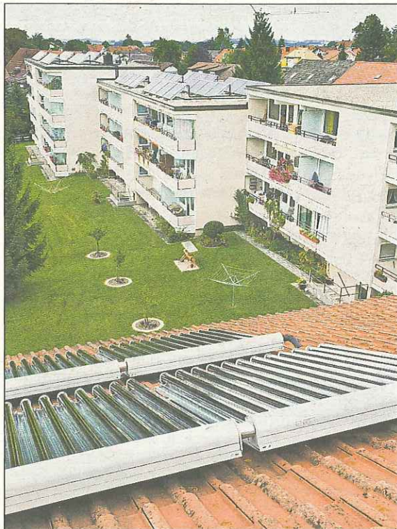
In Probstried wird eine Wohnanlage mit 52 Einheiten mit Solarenergie und Pellets geheizt.
